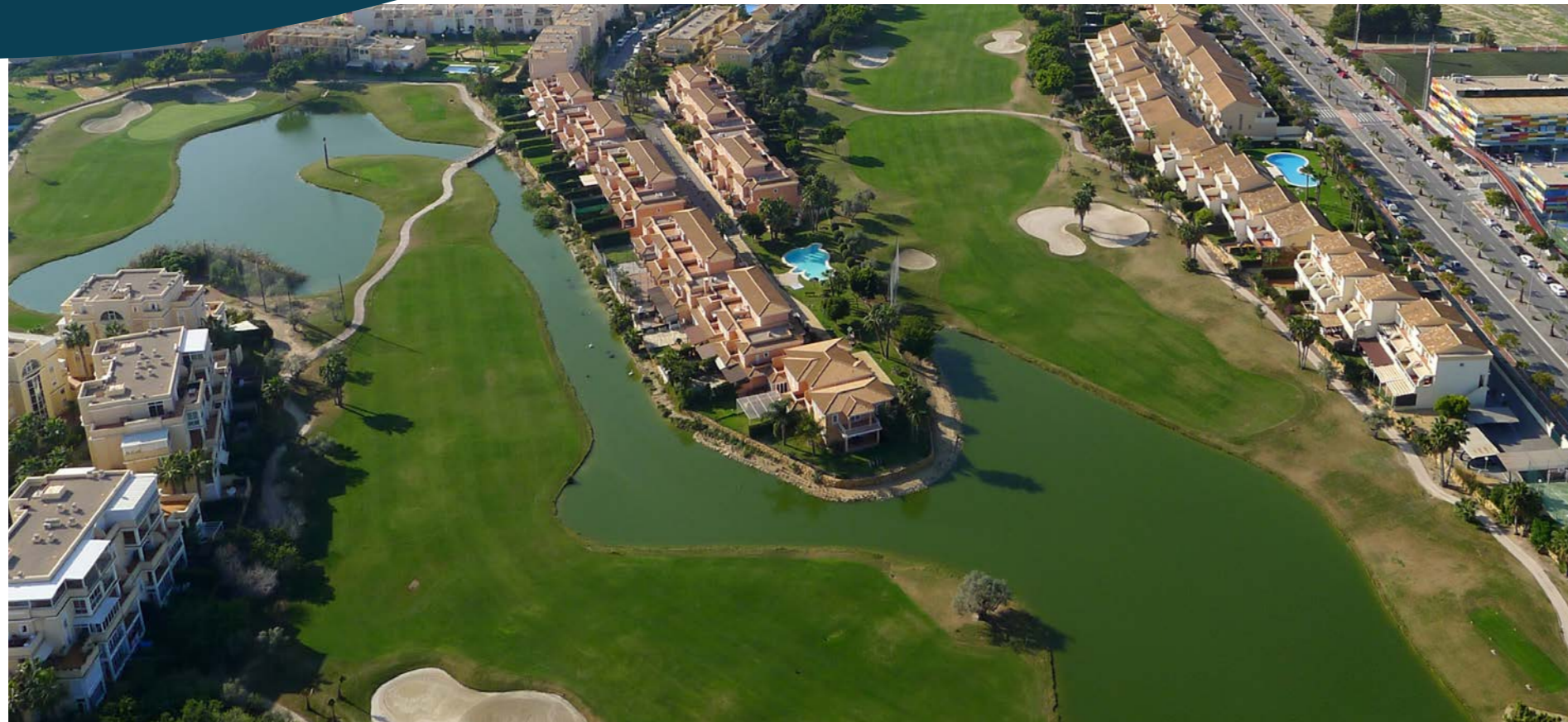
PANORÁMICA DEL CAMPO DE GOLF DE ALICANTE GOLF / PANORAMIC VIEW OF THE ALICANTE GOLF COURSE
